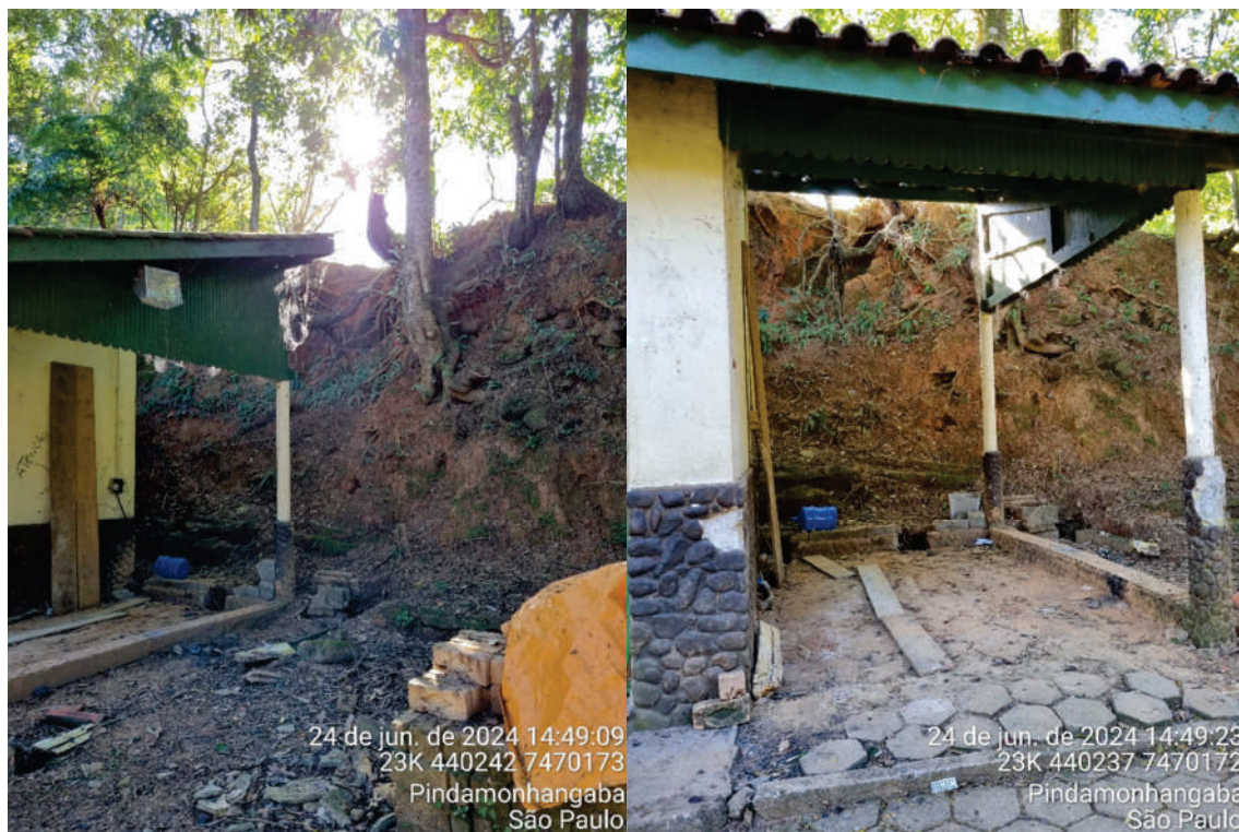
Figura 53 - Processos erosivos em talude - Parque Reino das Águas Claras
