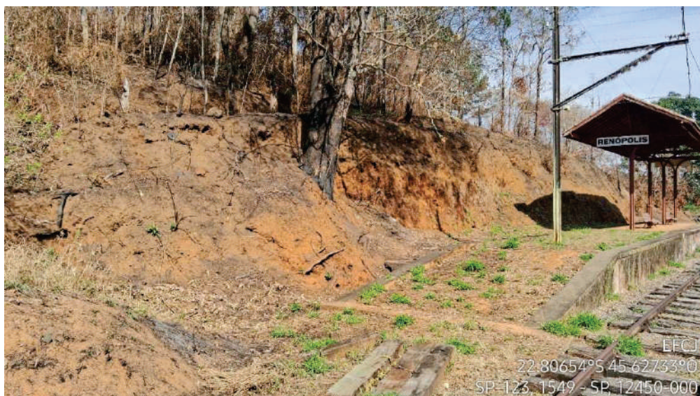
Figura 59 - Talude com processos erosivos intensos - Parada Renópolis
