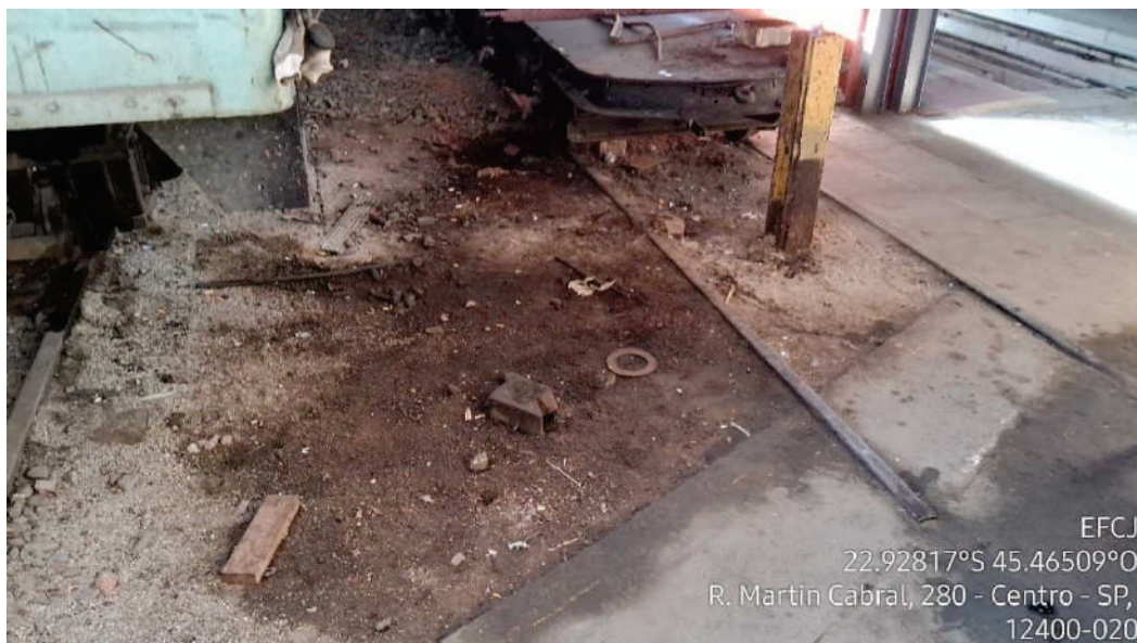
Figura 3 - Área de estacionamento de vagões e locomotivas com manchas de óleo em solo exposto - Pátio de Manutenção de Pindamonhangaba
