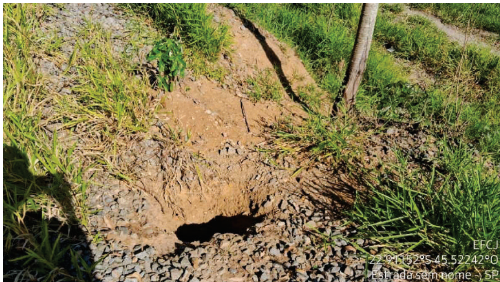
Figura 34 - Erosão laminar à jusante da via permanente
