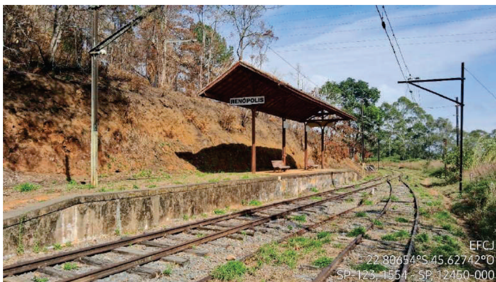
Figura 60 - Talude com processos erosivos intensos - Parada Renópolis
