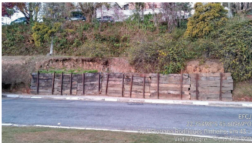
Figura 77 - Contenção improvisada com trilhos e dormentes
